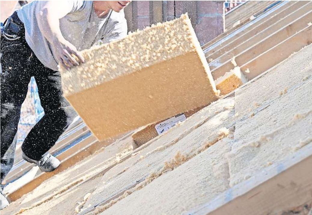
Holzfaser-Dämmstoffe eignen sich sehr gut zur Schalldämmung. Bewohner merken das vor allem im Dachbereich, wo Geräusche von Flugzeugen, Autoverkehr oder prasselndem Regen um etliche Dezibel leiser ankommen. FOTOS: HLC/STEICO
