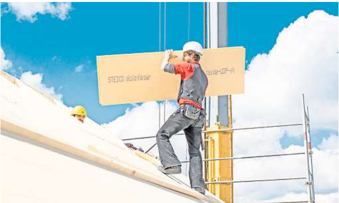
Holzfaser-Dämmstoffe eignen sich hervorragend zur Schalldämmung. Sie dämpfen störende Geräusche wie Fluglärm, Autoverkehr oder prasselnden Regen, was die Wohnqualität steigert.
