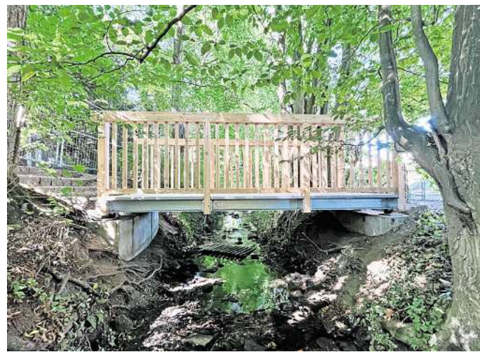
Fertig: So sieht die neue Brücke über den Mühlbach aus.
