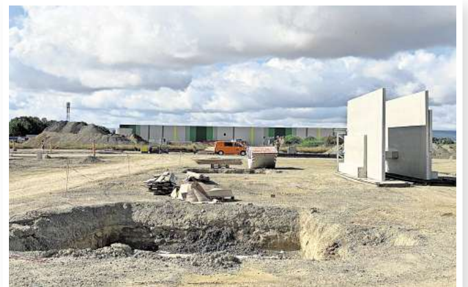
Fortschritt: Im Hintergrund ist die in Kürze fertige Halle von „Süd 2“ zu sehen. Davor entsteht, davon zeugen die großen Sandberge, bald die Halle von „Süd 1“.
