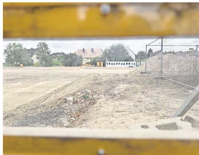
Blick durch das Fenster im Bauzaun: In den nächsten Tagen beginnen die Rohbauarbeiten auf der Fläche, wo in den vergangenen Wochen die Grundschule Am Castrum abgerissen worden ist. Vier neue Lernhäuser werden in etwa zwei Jahren die neue Schule bilden. FOTO: DIRK WIRAUSKY
