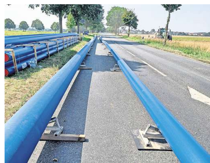
Bauarbeiten: In Barsinghausen bauen die Stadtwerke die Wasserleitung aus.
