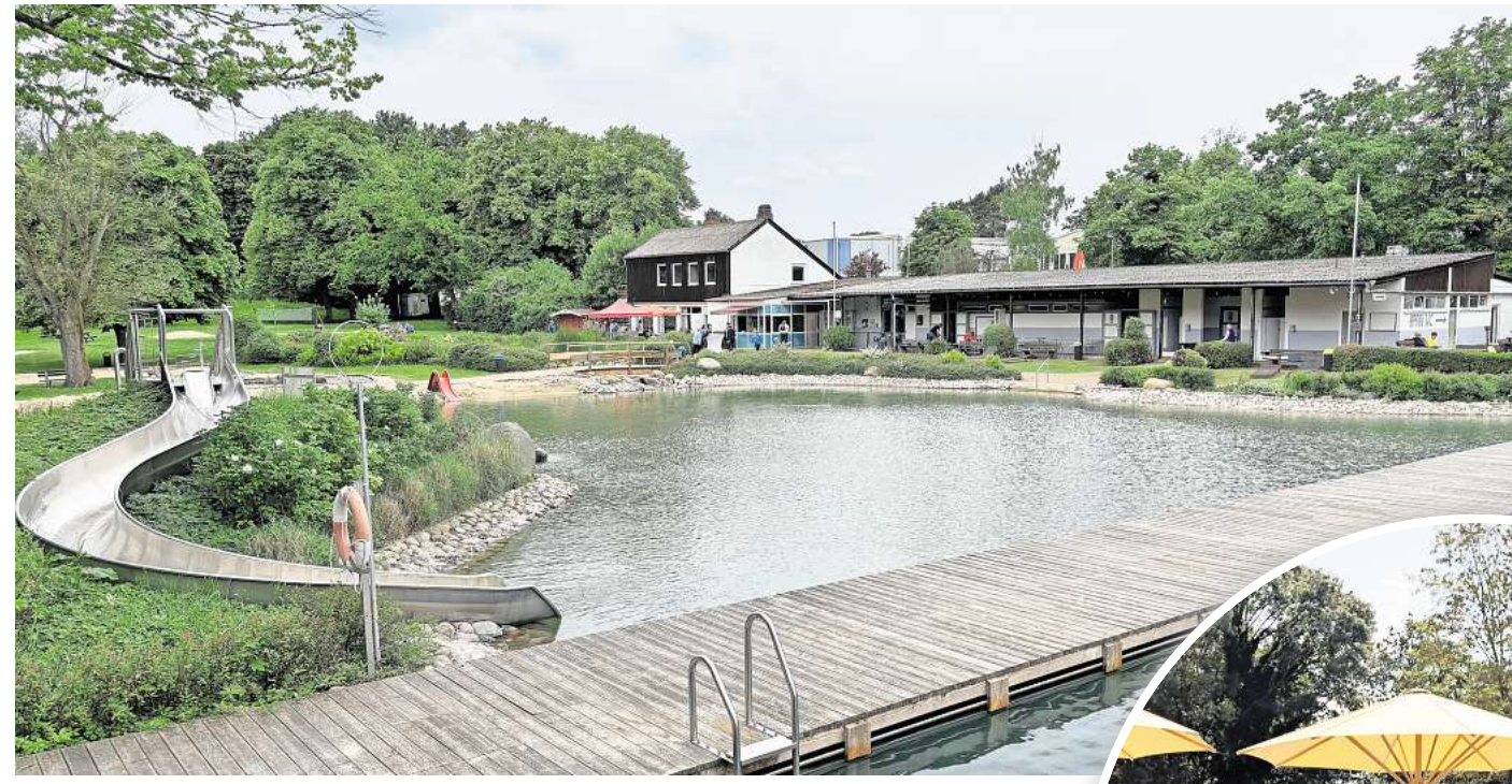
Über Pfingsten geschlossen: Der Wasserpark Wennigsen hat Probleme mit der Wasserqualität und muss deshalb an der Beckenfolie und dem Filter nachbessern. ANDRÉ PICHIRI
