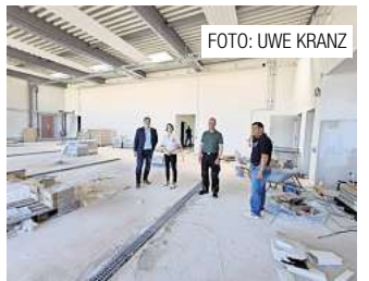
Baufortschritt in der neuen Fahrzeughalle in Degersen. Seite 7
