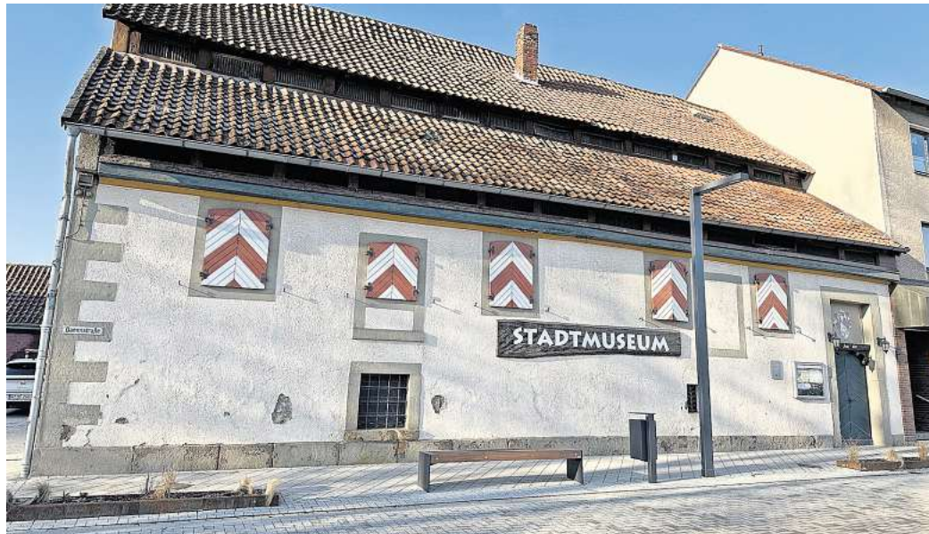
Große Pläne: Die Bürgerstiftung will das Gebäude des Stadtmuseums umfassend sanieren.
