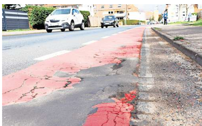
Kritik am Fahrradschutzstreifen auf der Schulstraße in Gehrden: Aus Sicht des ADFC gibt es in einem Streckenabschnitt zu viele Furchen, Huckel und Löcher im Asphalt.
