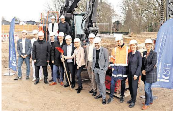
Gehrdens Bürgermeister Malte Losert (oben links), freut sich mit Regionspräsident Steffen Krach (Unten, Fünfter von links) sowie Landesminister Andreas Philippi (Sechster von links) über den ersten Spatenstich. FOTO: INGO RODRIGUEZ
