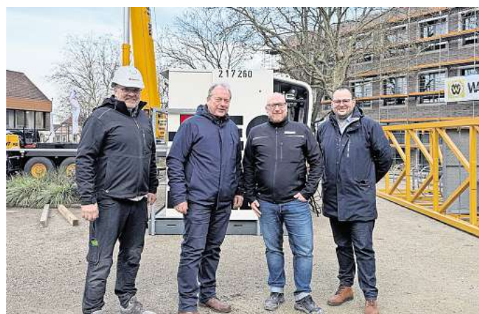
Fortschritt: Der zweite Kran an der Baustelle der Wilhelm-Stedler-Schule wird zurückgebaut.
