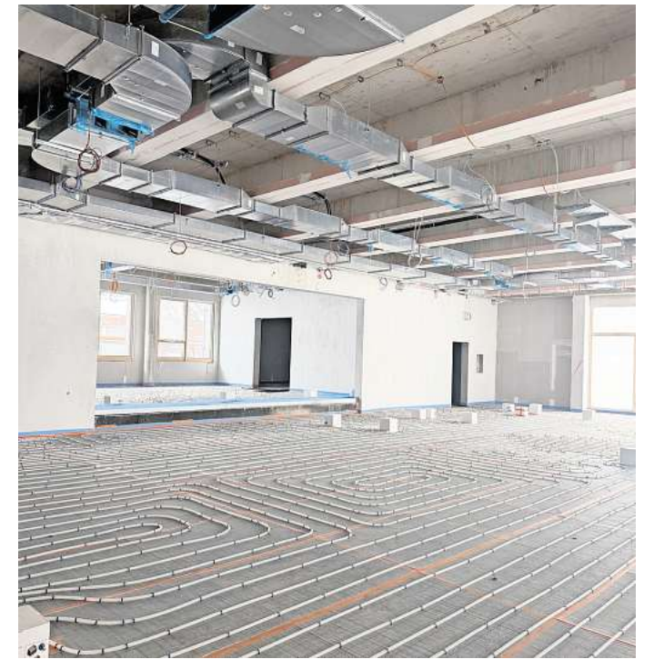
Fortschritt: Der Innenausbau der Wilhelm-Stedler-Schule erfolgt derzeit.
