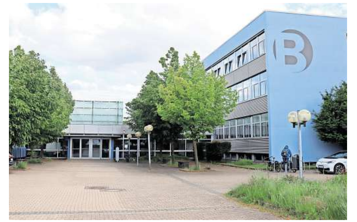
Der Ist-Zustand: Der Umbau des Schulzentrums Am Spalterhals ist die teuerste Baumaßnahme. Derzeit liegt die Schätzung bei 88 Millionen Euro.
