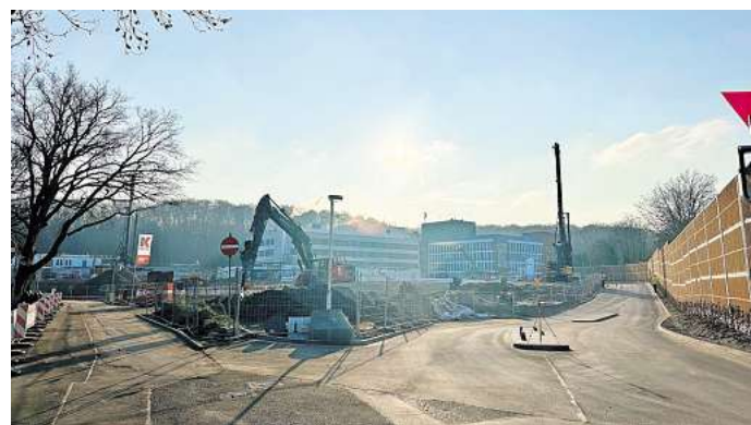
Riesige Baustelle: Am Gehrden Krankenhaus wird ein Ersatzneubau errichtet. Die Erdarbeiten haben inzwischen begonnen. FOTO: DIRK VIRALUSKY
