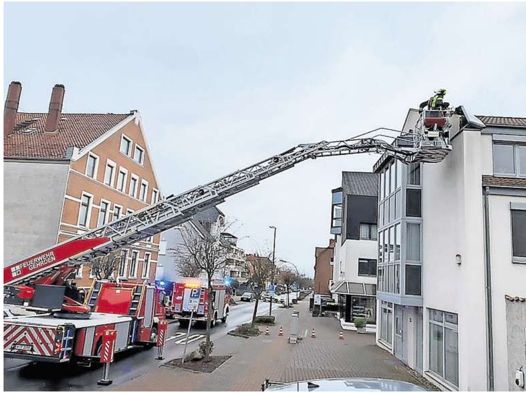
Sicherung: Die Feuerwehrleute befestigen Teile der Dachkonstruktion eines Geschäftshauses an der Gartenstraße.
