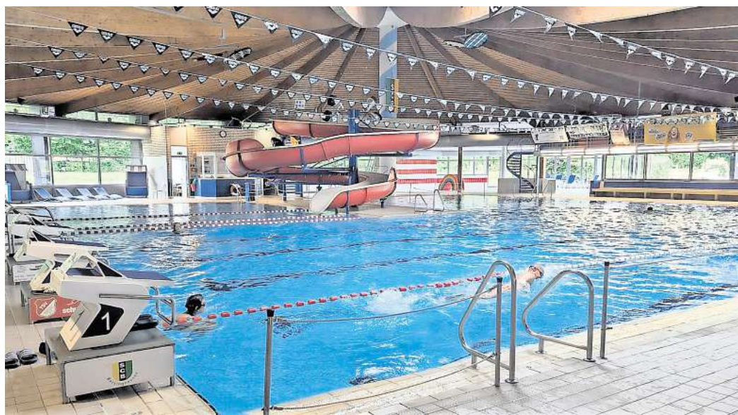
In die Jahre gekommen: Das Deisterbad ist über 50 Jahre alt und soll durch einen Neubau ersetzt werden.
