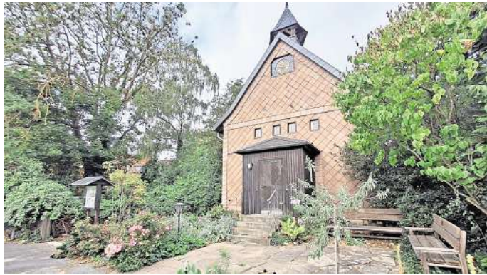
Zählt auch zu den Immobilien des Gehrden Gemeindeverbandes: Die kleine Kapelle in Benthe soll ebenfalls mit Instandsetzungen für die nächsten zehn bis 20 Jahre gesichert werden.
