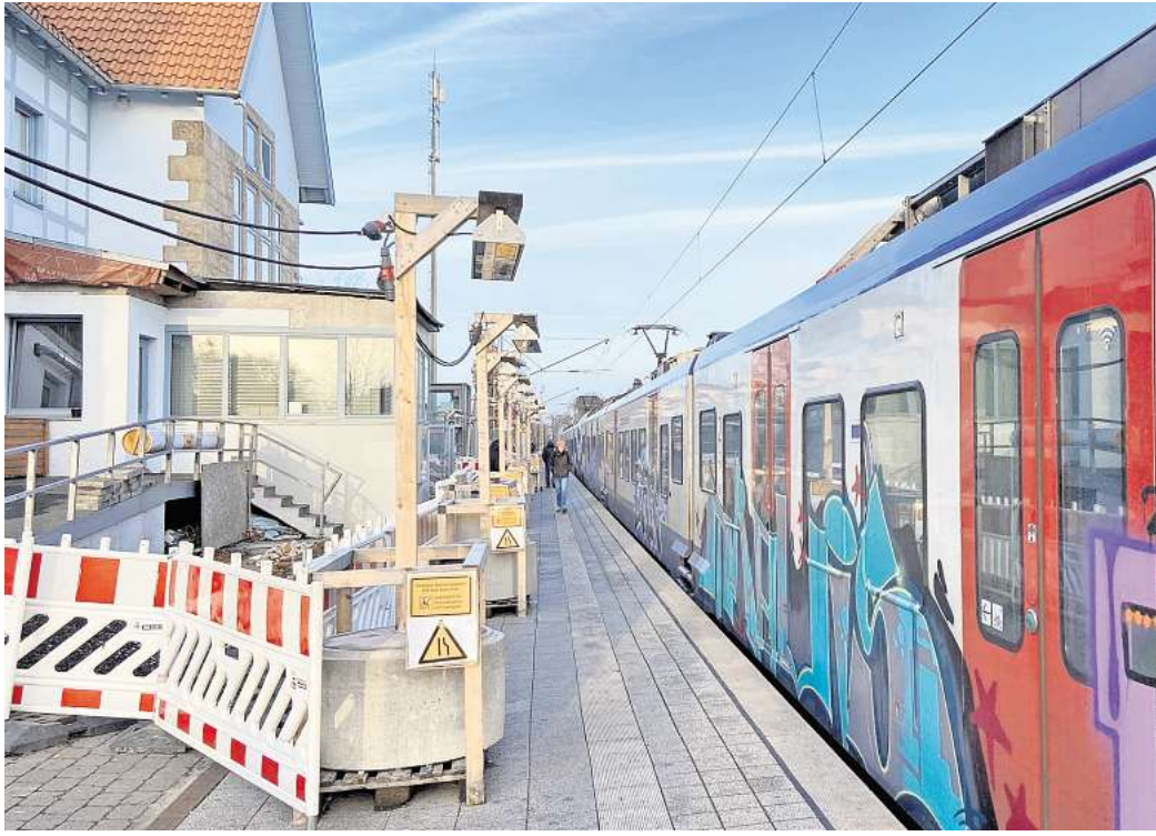
Baustelle an Gleis 1 in Barsinghausen: Das alte Bahnsteigdach wurde abgebaut. Aufgrund von Schwierigkeiten im Bodengrund im Bereich der Fundamente ziehen sich die Arbeiten nun aber schon seit Monaten hin. FOTO: JENNIFER KREBS
