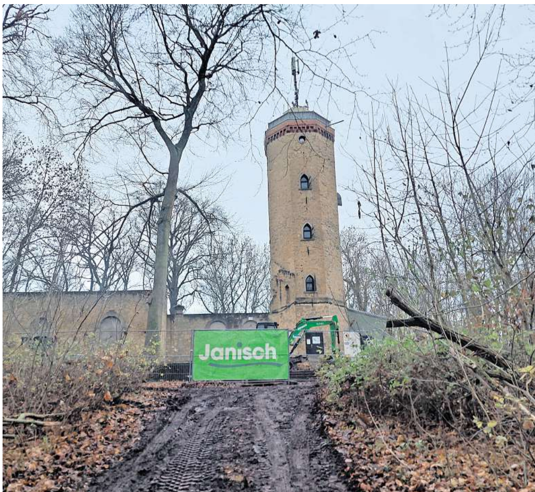
Eigentlich ein idyllisches Plätzchen: Vor dem Burgbergturm am Gehrdeener Berg ist momentan eine Baustelle.
