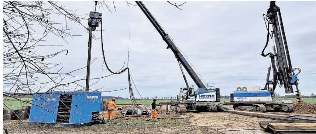
Großes Gerät: Zwischen Weetzen und Lemmie treiben die Tiefbauer Spundwände in den Boden. Für das Südlink-Kabel werden hier Mini-Tunnel unter der Bahnlinie hindurch gebaut.
