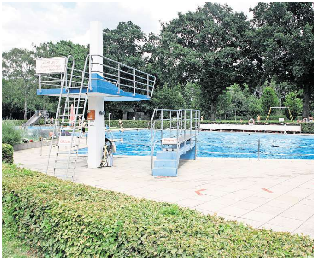
Das sanierungsbedürftige Freibad in Goltern: Die Stadtverwaltung setzt auf Förderung vom Bund in Millionenhöhe.
