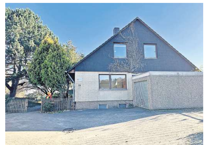
Verwaistes Haus: In das Gebäude der von der Stadt geschlossenen Kita Dammstraße soll im nächsten Jahr eine Elterninitiative einziehen. Doch noch fehlt die Betriebslaubnis.
