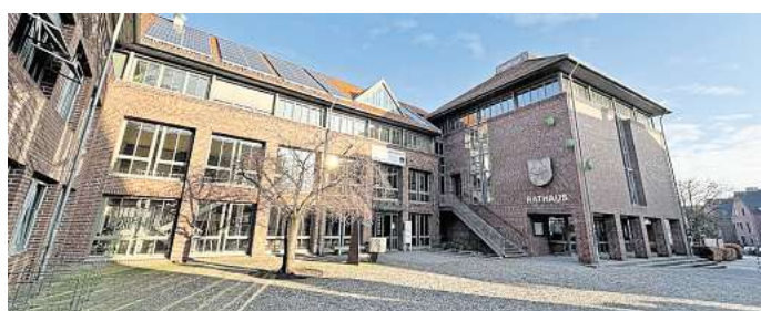
Modernisierung: Das Gehrden Rathaus soll für rund 7,3 Millionen Euro um einen zusätzlichen Trakt erweitert und umfassend erneuert und umgestaltet werden. FOTO: DIRK WIRAUSKY
