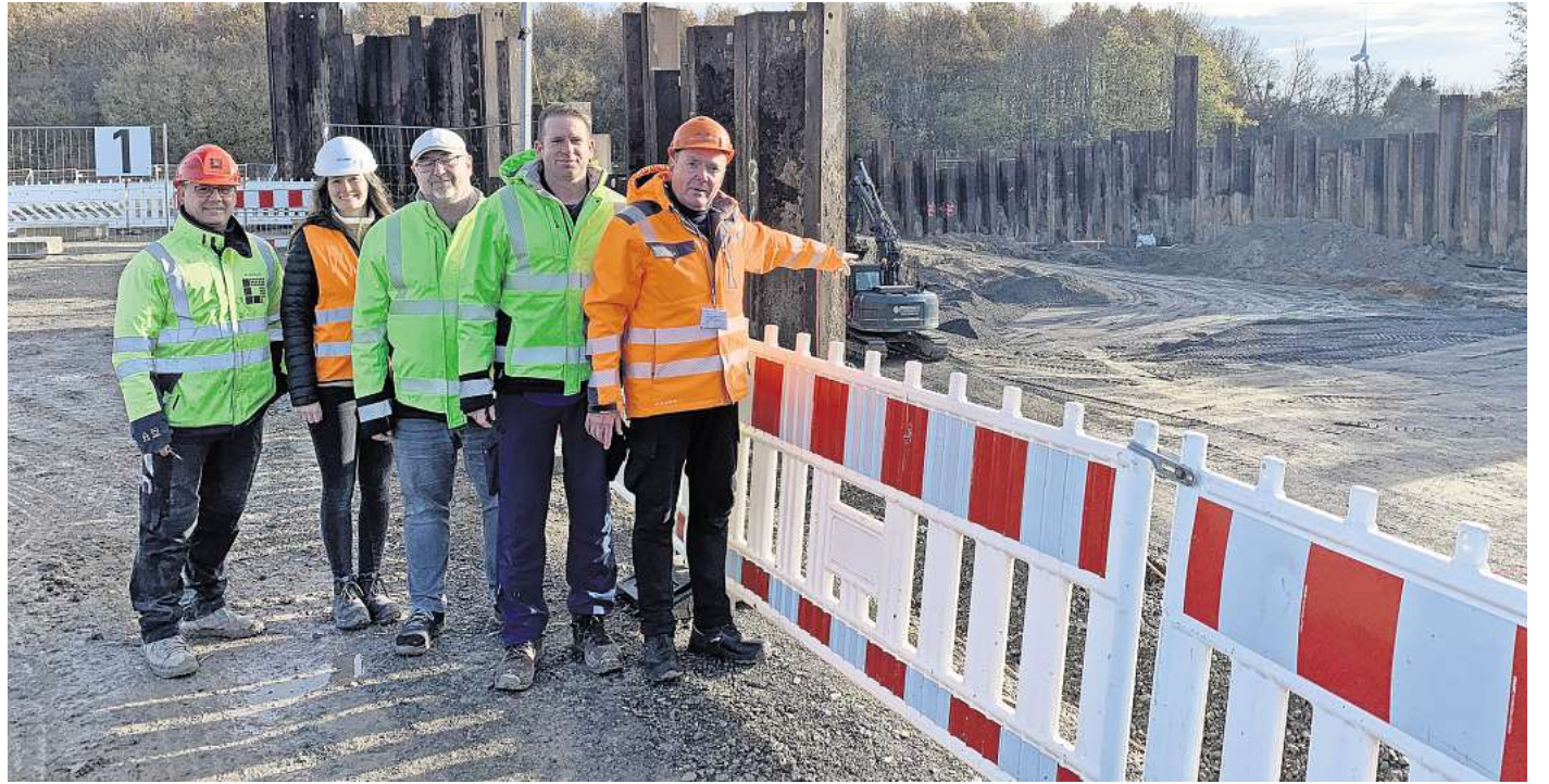
Vor der Baugrube: Die Beteiligten zeigen sich zufrieden mit dem Fortschritt des Wasserwerk-Neubaus in Eckerde.
