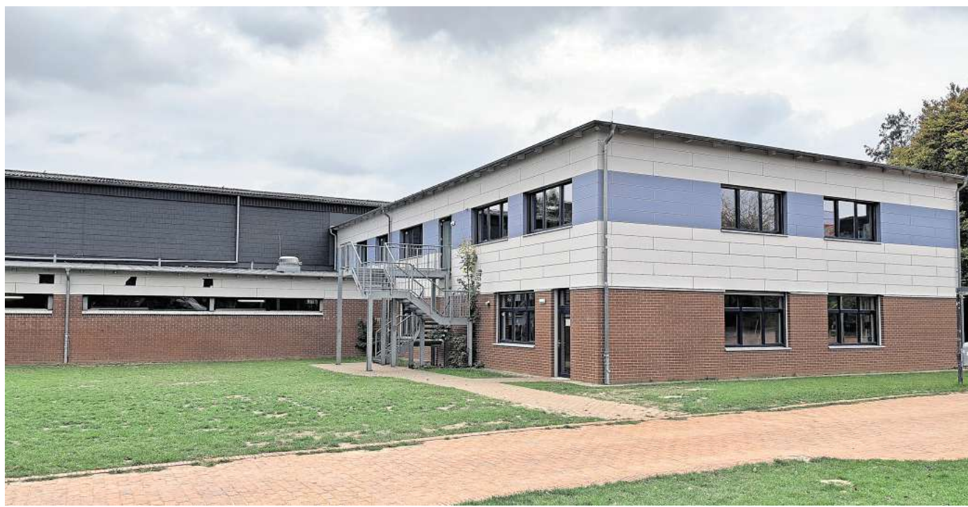
Hier läuft bis Jahresende nichts mehr: Die Sporthalle der KGS Wennigsen bekommt einen neuen Fußboden. Vereine müssen auf andere Trainings- und Spielstätten ausweichen.
