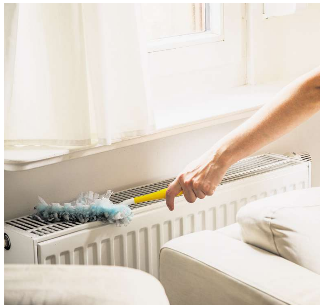
Saubere Heizkörper: Staub und Schmutz mindern die Wärmeabgabe und sollten regelmäßig entfernt werden.
