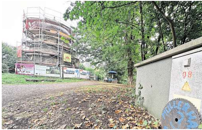
Eingerüstet: Der Verein Burgbergfreunde hat einen Pachtvertrag für die Mühle unterschrieben – mit dem Ziel, das 1878 errichtete Bauwerk zu sanieren. Künftig sollen ein Kaffee- und Biergarten, aber auch Kulturveranstaltungen regelmäßig Ausflüglerinnen und Ausflügler anlocken.
