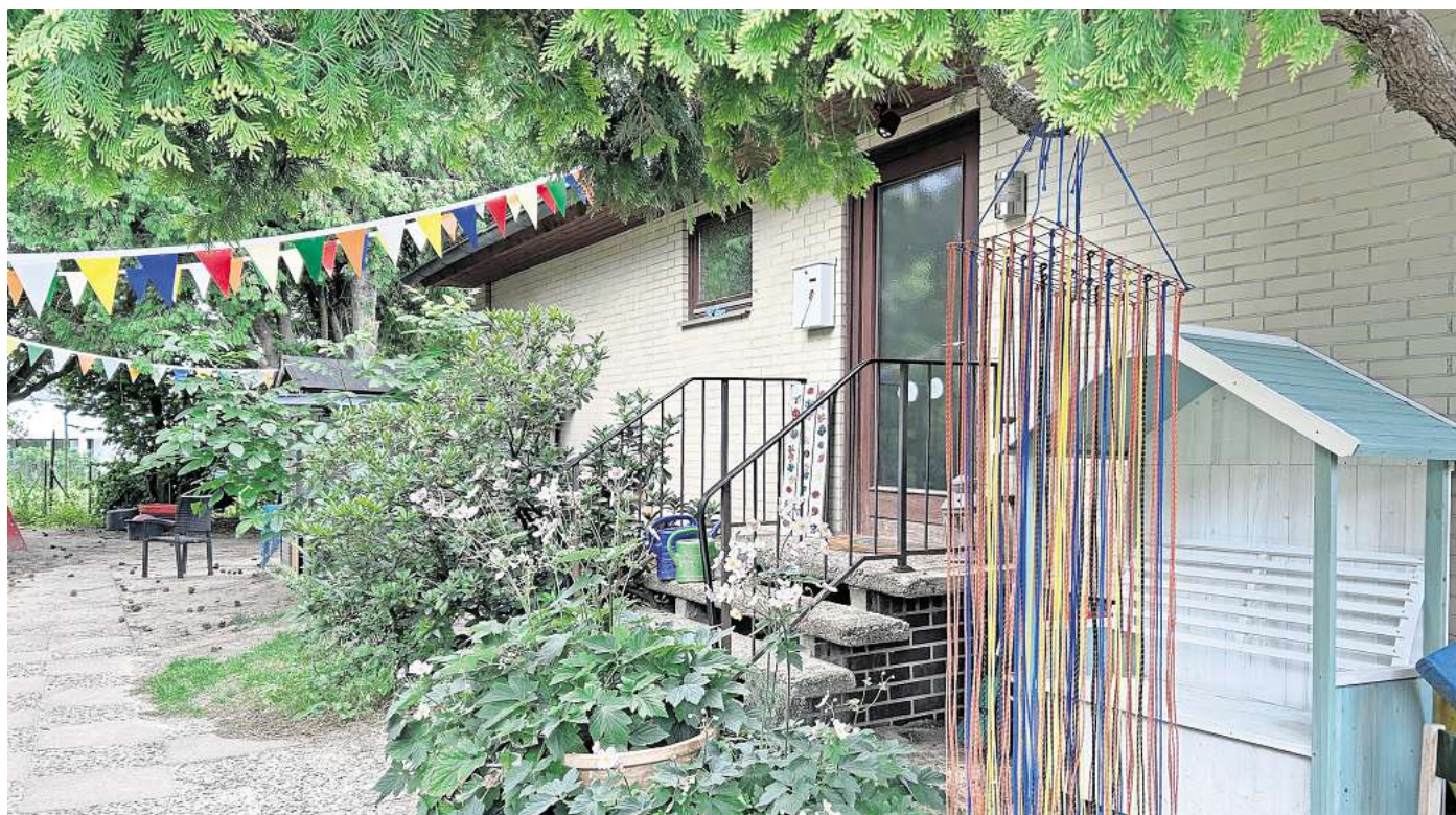
Die Stadt wird die Einrichtung an der Dammstraße aufgeben. Eine Elterninitiative soll das Gebäude nun übernehmen.
