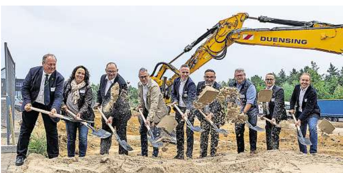
Los geht's: Planer, Verantwortliche und der Bürgermeister der Stadt Barsinghausen, Henning Schünhof (links), beim offiziellen Spatenstich. FOTO: KNAUF INTERFER
