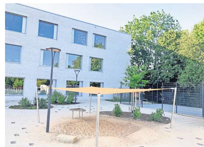
Schulhof: Das Sonnensegel befindet sich auf dem Gelände, wo derzeit noch die Grundschule Am Castrum untergebracht ist.
