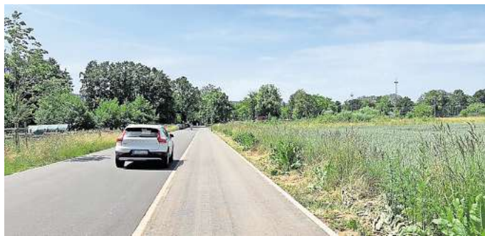
Bröhnweg in Wennigsen: Die Bremsschwellen wurden nach der Sanierung der Fahrbahn nicht wieder eingebaut. Die Verwaltung tendiert stattdessen zu einer anderen Variante. FOTO: ANDRE PICHIRI
