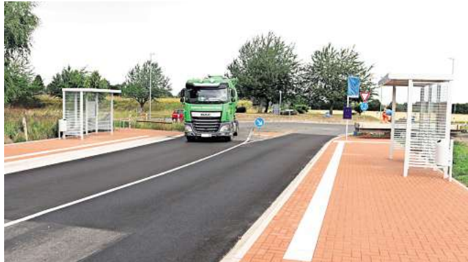
Unmittelbar an der Aus- und Einfahrt des Kirchdorfer Kreisels: Die neuen Bushaltestellen stehen wegen ihrer ungünstigen Lage schon vor ihrer Inbetriebnahme in der Kritik.
