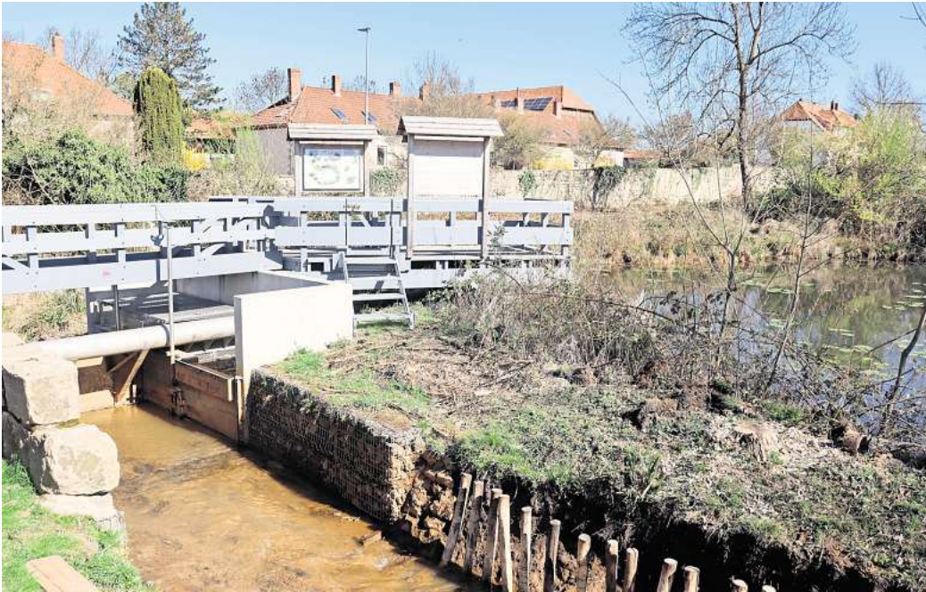
Wurde vor vier Jahren komplett erneuert: Die Wehranlage an der Bredenbecker Beeke soll unter anderem eine verbindliche Stauhöhe gewährleisten, um das Holzfundament des Rittergutes feucht zu halten.
