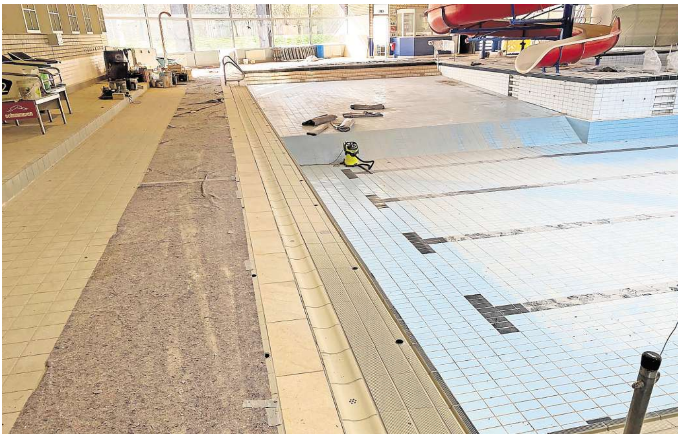
Neuer Anblick: Das Gerüst ist verschwunden und der Beckenkopf fertig gefliest.
