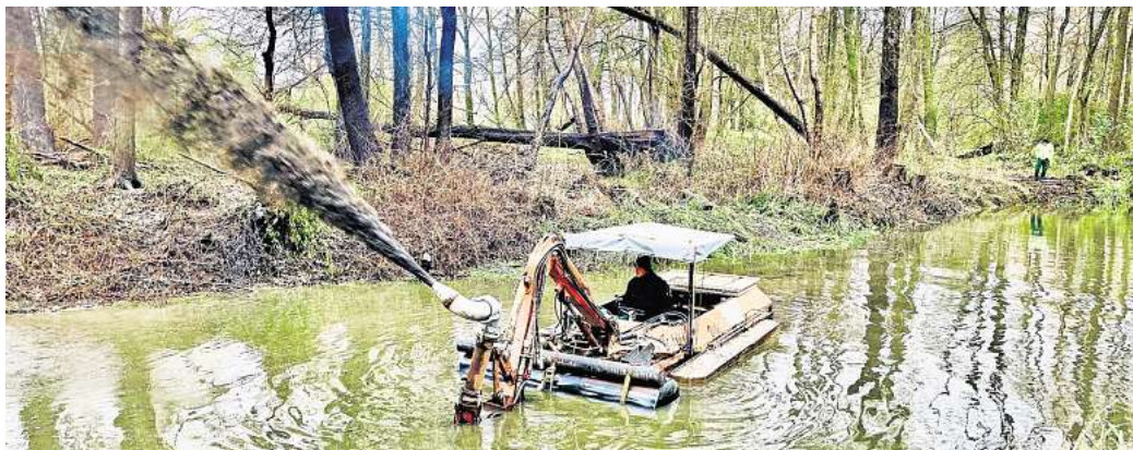
Schlammkanone: Unbelasteter Schlamm aus einem Teich kann auf dem Grundstück bleiben.
