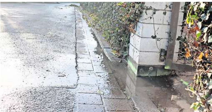
Pfützen: Nach Einschätzung des Anwohners Ewald Zechmeister sammelt sich wegen des neuen Gefälles der sanierten Straßenoberfläche abfließendes Wasser in der Gosse vor seinem Grundstück und läuft wegen einer zusätzlich mangelhaften Erneuerung seines Bordsteines schließlich durch das Erdreich in seinen Keller.
