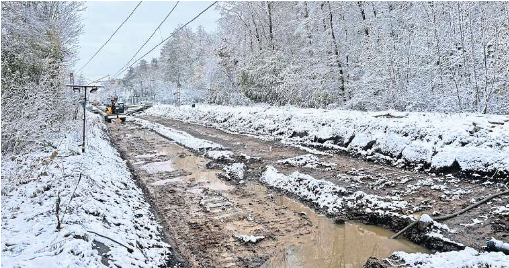
Hier sind die alten Schienen schon runter: Die Deutsche Bahn erneuert die Gleise zwischen Egestorf und Barsinghausen.
