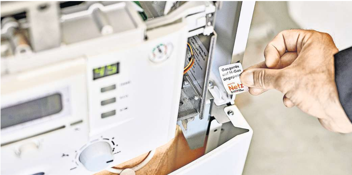
Bereit für H-Gas: Mit einer Plakette werden diejenigen Geräte markiert, bei denen die Anpassung erfolgt ist.
