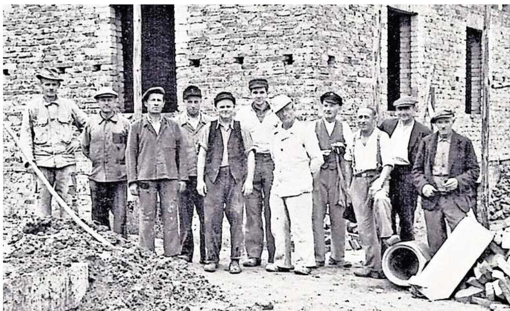
Ein Foto von 1949: In dieser Gruppe befanden sich die acht Bauherren, die die Häuser an der Hangstraße und am Rosenweg errichteten. Als Zweiter von links ist Fritz Temps zu sehen, der Vater von Helmuth Temps.
