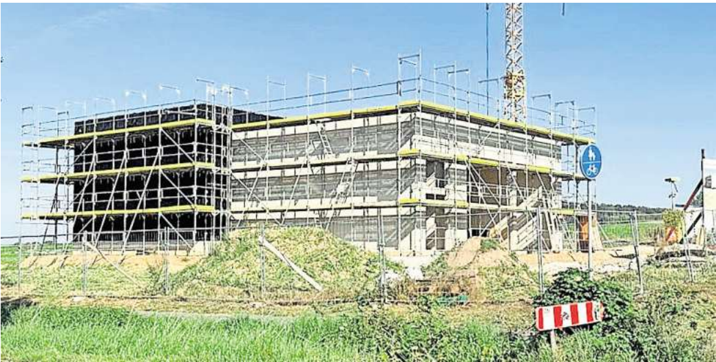
Der Bau schreitet voran: Das neue Feuerwehrhaus in Lemmie nimmt Gestalt an.
