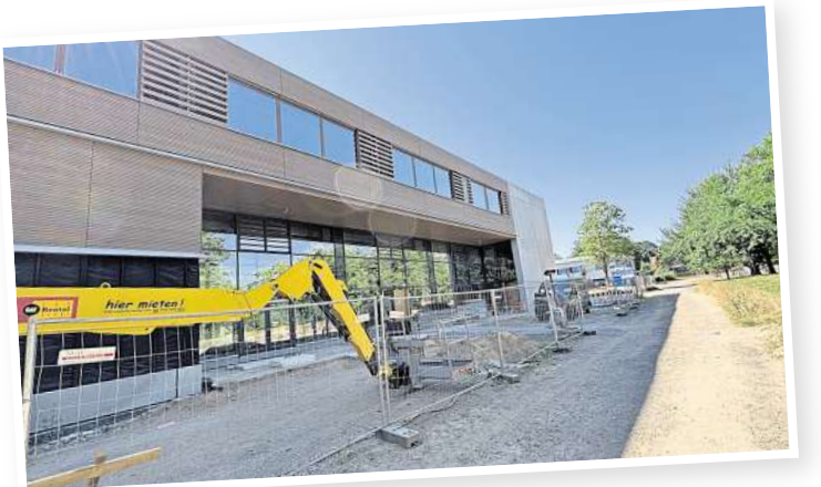
Fassade ist zu erkennen: Das ist die neue Mensa von außen. Im Obergeschoss werden sich Unterrichtsräume befinden.
