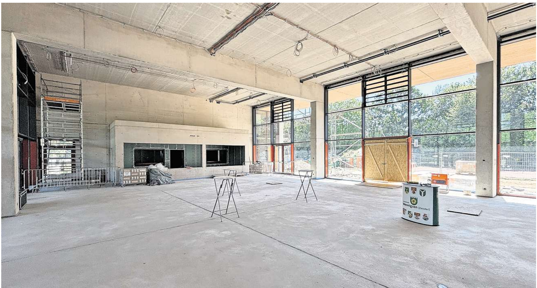
Noch in Rohbau: Das wird die neue Mensa in der KGS sein.
