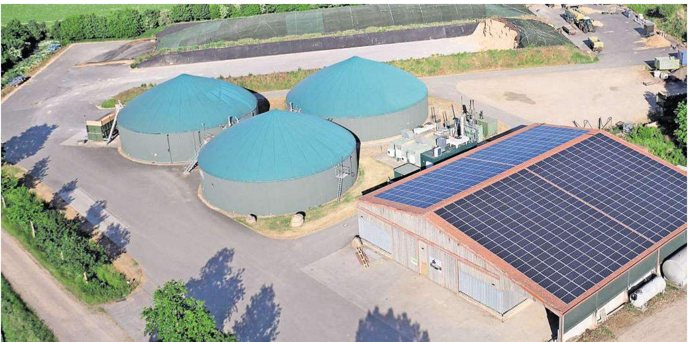
Stilllegung rückt immer näher: Die Biogasanlage in Lenthe steht gut 20 Jahre nach ihrer Inbetriebnahme wegen kostspieliger Produktionsauflagen und sinkender Energieeinspeisevergütungen vor dem Aus.
