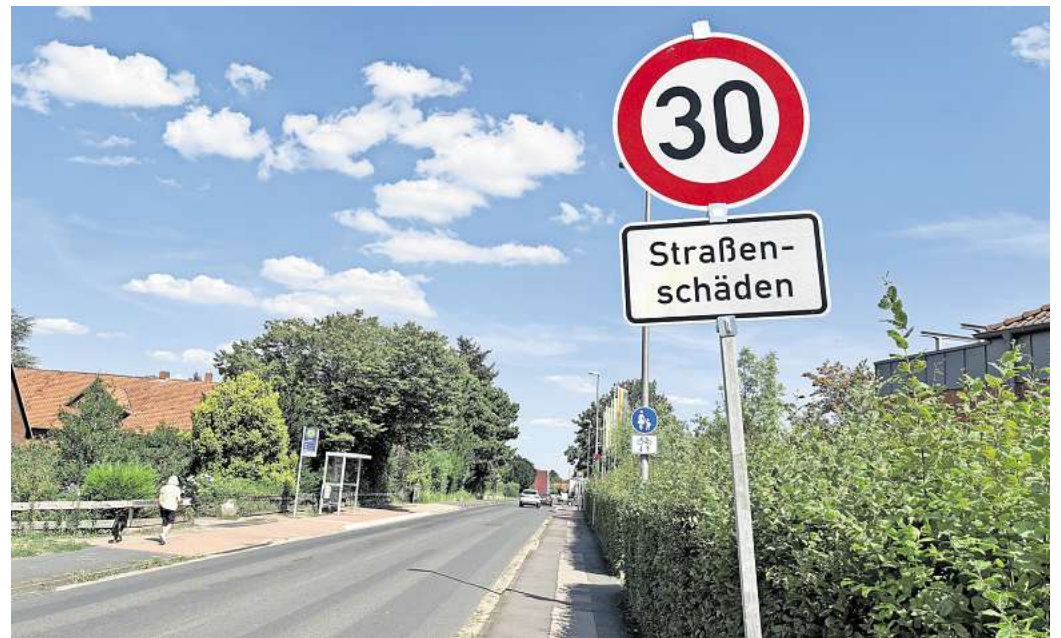
Tempo 30 wegen Straßenschäden: Die L391 in Egestorf, hier die Stoppstraße, ist in einem schlechten Zustand.
