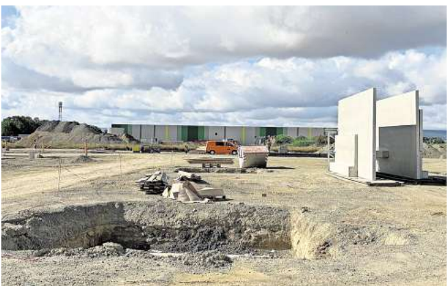
Fortschritt: Im Hintergrund ist die in Kürze fertige Halle von „Süd 2“ zu sehen. Davor entsteht, davon zeugen die großen Sandberge, bald die Halle von „Süd 1“.
