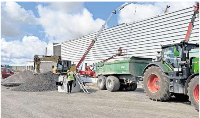
Bei der Arbeit: Durchschnittlich sind 200 Personen pro Tag auf der Baustelle im Einsatz.
