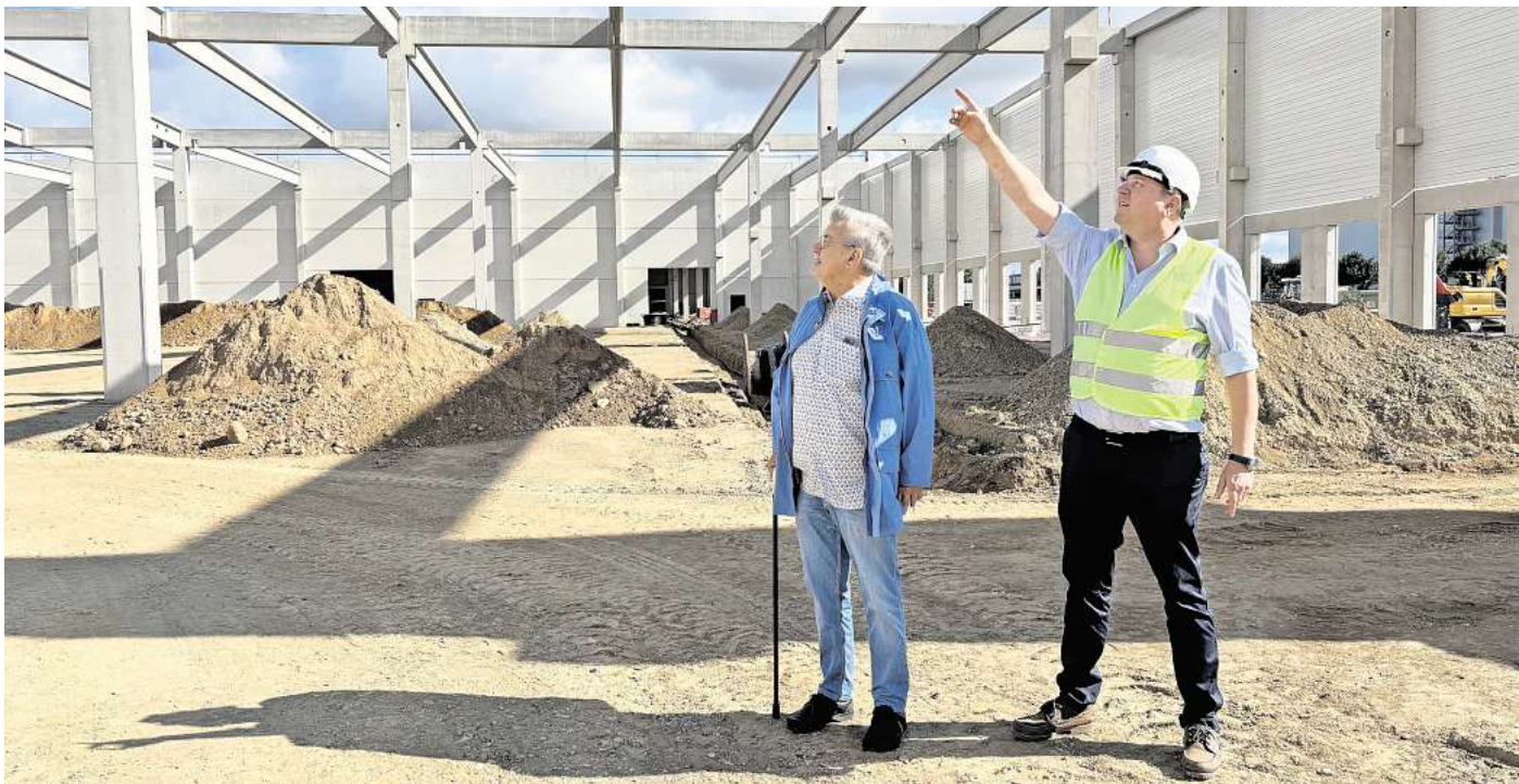
Schauen sich die Baustelle an: Bernd Rathenow (links) und Götz Harbart begutachten den Fortschritt in der späteren BMX-Lagerhalle.
