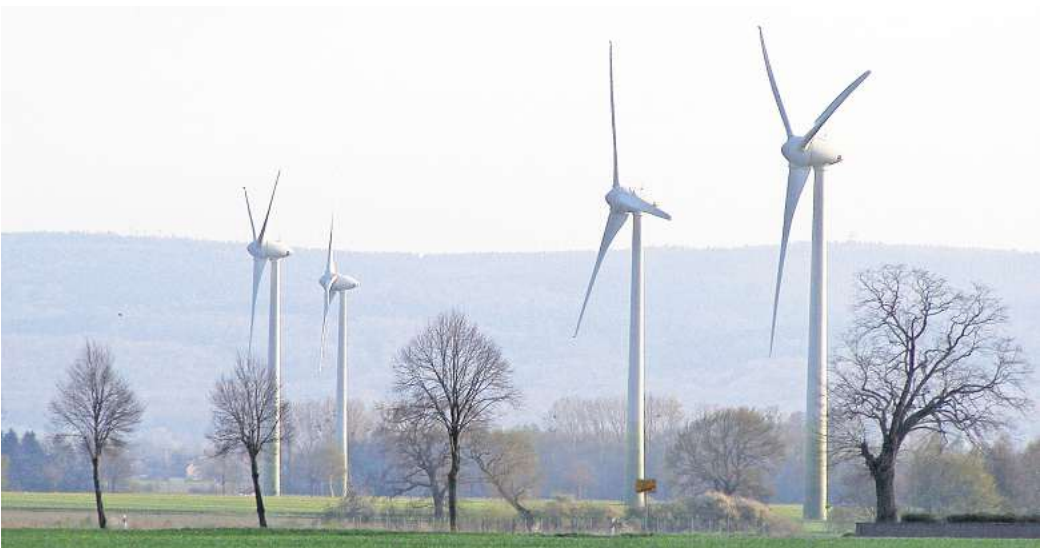
Bei Leveste drehen sich bereits seit Jahren mehrere Windräder. Bei Redderse sollen ein weiterer Windpark gebaut werden. FOTO: INGO RODRIGUEZ (ARCHIV)
