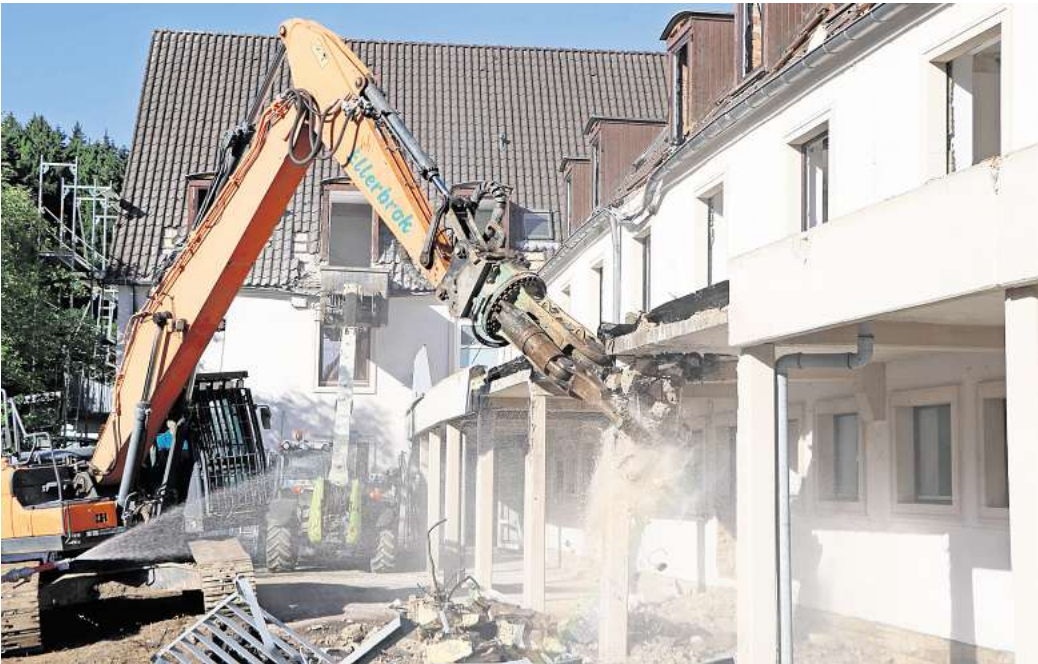
Der Abriss läuft: Am Sporthotel Fuchsbachtal in Barsinghausen übernehmen Bauarbeiter.
