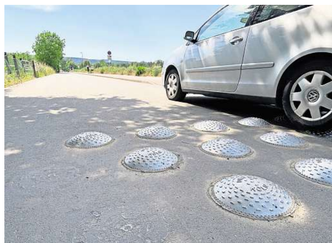
Sechs Zentimeter hoch und jeweils in Dreierreihen verlegt: Mit „Kölner Teller“ sollen Autofahrer auf dem Bröhnweg dazu gebracht werden, die vorgeschriebene Geschwindigkeit von maximal Tempo 30 einzuhalten.
