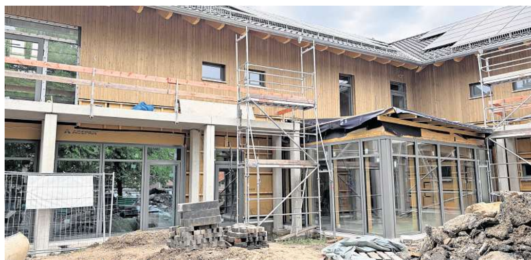
Noch eine Baustelle: Der Eingangsbereich der Kita ist schon zu erkennen.
