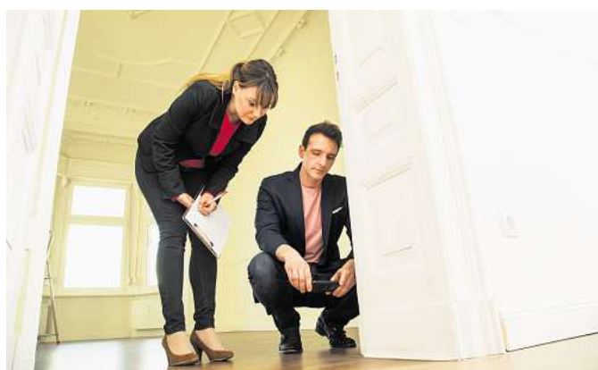
Möglicher Pilzbefall: Vor dem Kauf sollte ein Altbau von einem unabhängigen Sachverständigen kontrolliert werden.
