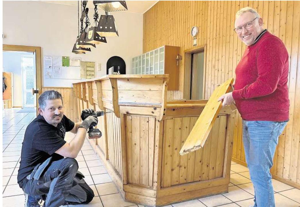
Tresen wird komplett erneuert: Lars Reichardt (links) und Holger Urbaneck vom Vorstand der Dorfgemeinschaft Evestorf haben mit der Demontage des Tresens im DGH begonnen.
