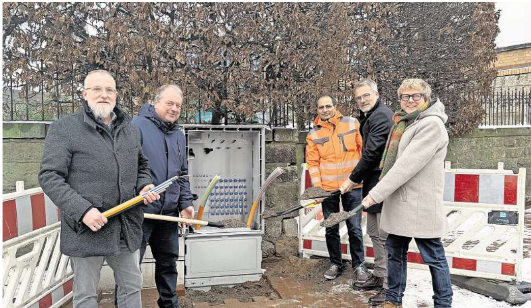
Symbolischer Spatenstich für den Glasfaserausbau in Barsinghausen: Hartwig Bode (Abteilungsleiter Planung und Bau Avacon Connect, von links), Bürgermeister Henning Schünhof (SPD), Rajeh Romhein (städtisches Tiefbauamt), Andreas Niehaus (Vertriebsleiter bei Avacon Connect) und Barsinghausens Wirtschaftsförderer Timo Muchow.
