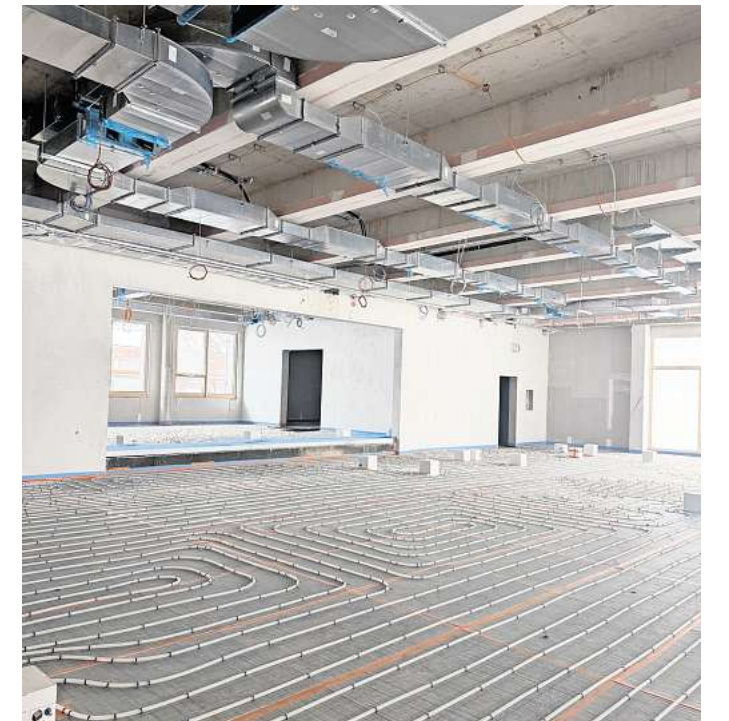
Fortschritt: Der Innenausbau der Wilhelm-Stedler-Schule erfolgt derzeit.
