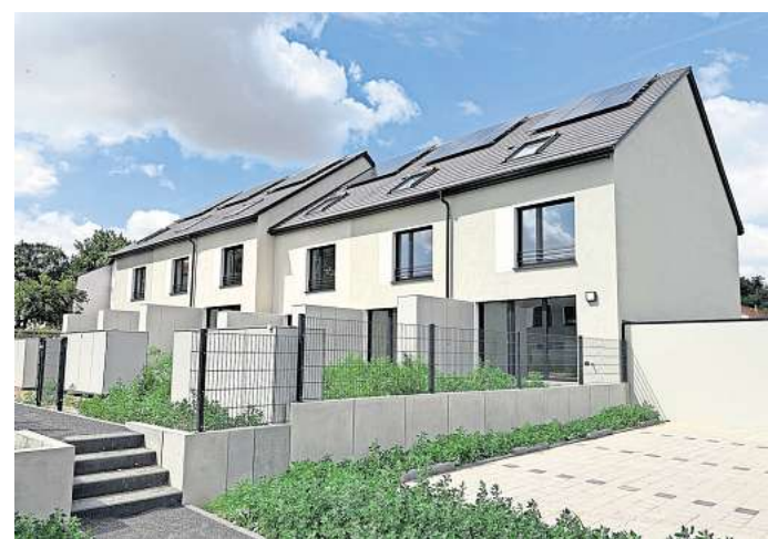
Fertiggestellt: Die ersten Reihenhäuser sind bezugsfertig.
