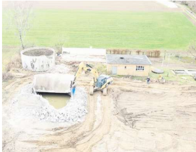
Am Sutfeldweg in Weetzen entsteht ein neuer Lagerplatz für den städtischen Bauhof: Auf dem ehemaligen Klärwerksgelände wurden bereits Ende des vergangenen Jahres die notwendigen Abrissarbeiten erledigt.
